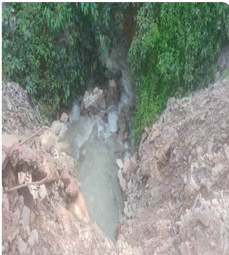
La source du fleuve Kabèlè polluée par les activités de CRCC18 (Image prise le 21/08/2025)
